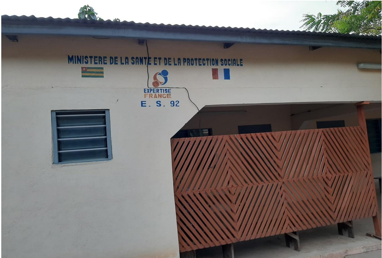
Bâtiment Hôpital de jour
