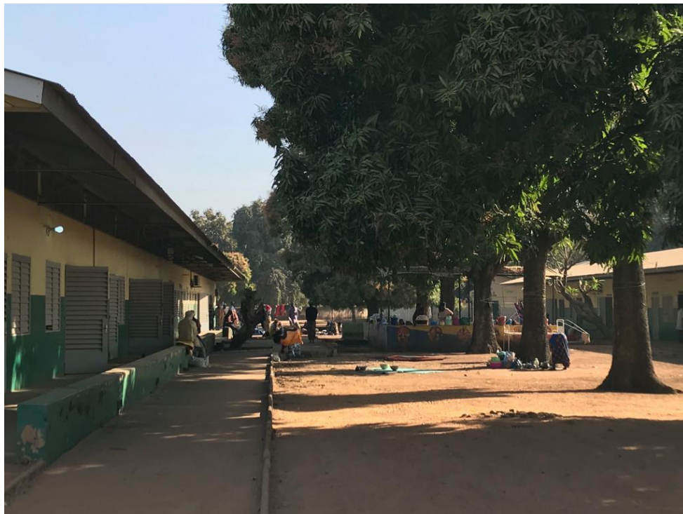
L'hôpital de Moundou : hôpital pavillonnaire construit dans les années 1950 (Le circuit d'eau et d'électricité est vétuste et mériterait une réfection totale)
